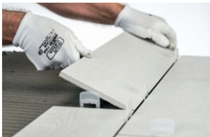
colocação do pavimento
