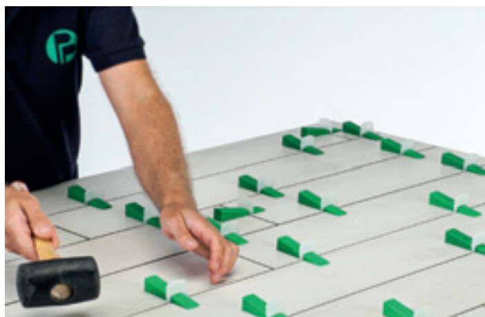
remoção das cunhas e dos espaçadores
