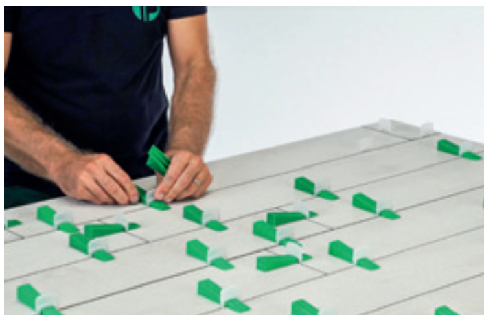
inserção das cunhas de nivelamento
