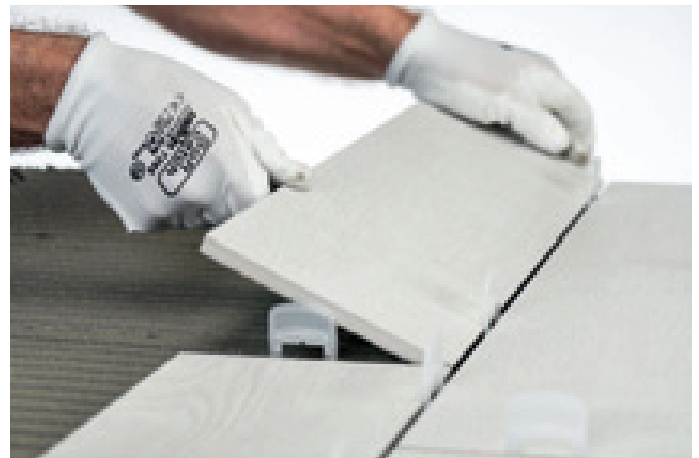
pose du carrelage
